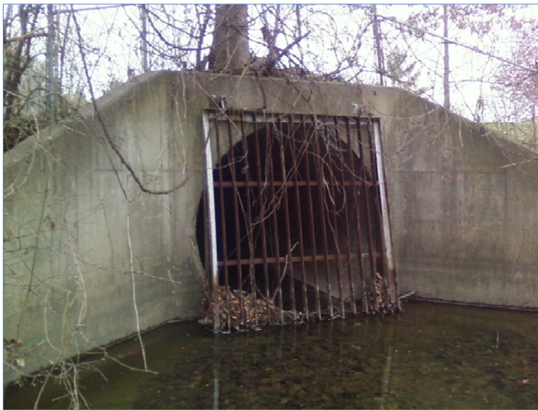
Site 1 Beitz Drain Outlet
